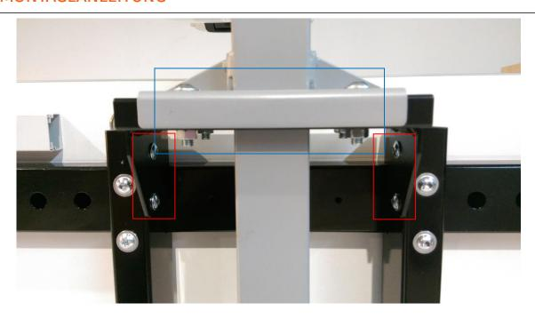
**4x Allen head lens screw with flange M8x35** Linsenkopfinbusschraube mit Flansch **4x selflocking nut M8** selbstsichernde Mutter **4x washer 8mm** Unterlegscheibe
